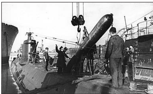
Погрузка торпед на подводную лодку Л-23
